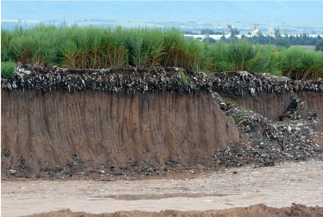
Imagen n° 4. Sector de donde se extrae el suelo orgánico para la cobertura final de las celdas. No debiera usarse esta tierra para la cobertura ya que tiene residuos del antiguo basural.
