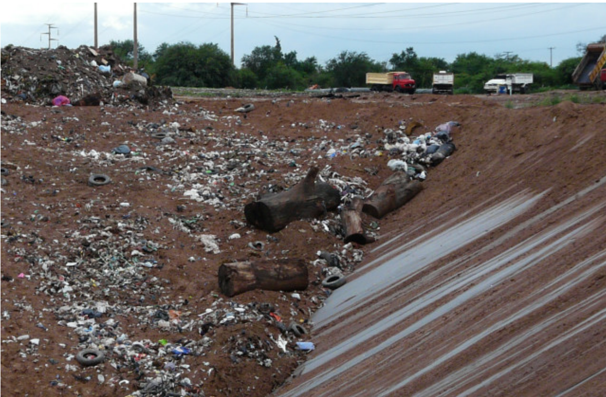
Imagen n° 5. Residuos voluminosos. Obsérvese su proximidad a la membrana y el riesgo de rotura de la misma.
