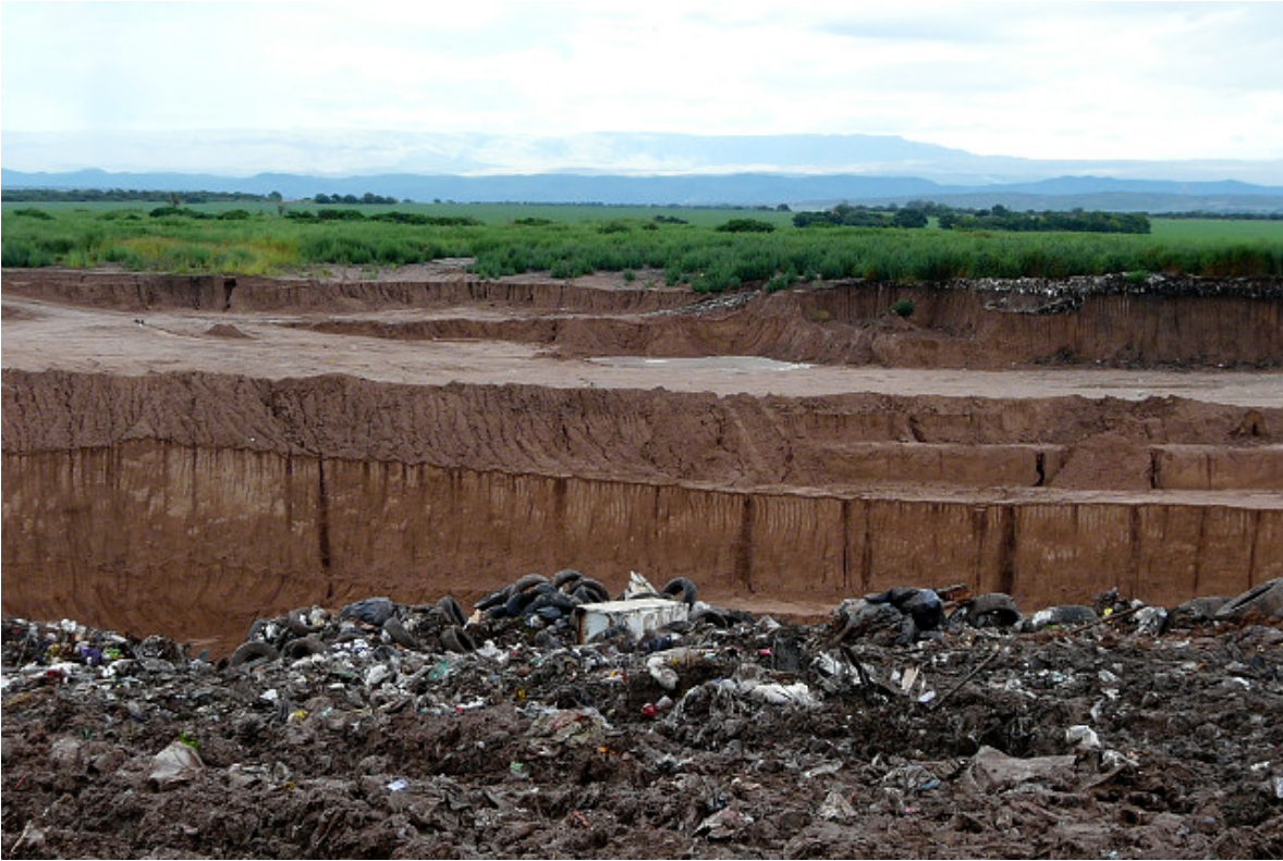
Imagen n° 6. Obsérvese la presencia de neumáticos en el frente de trabajo de esta celda.
