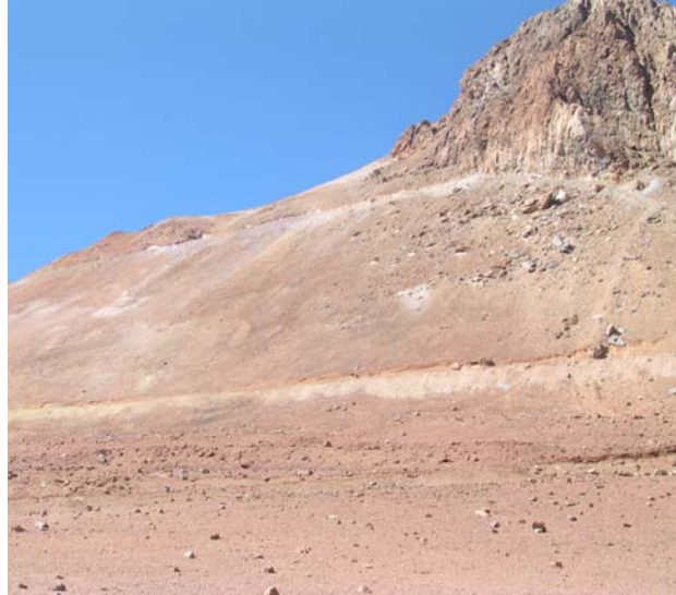
Figura 29: Caída de rocas en el valle del Río Potrerillos.
