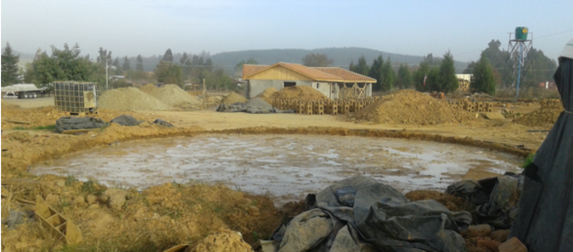
Un estanque para la mezcla de arcilla adyacente a un sitio de producción de ladrillos tradicionales. Cauquenes, Chile
